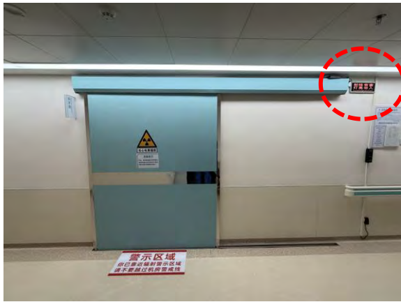
图 3-5 病人出入机房防护门
