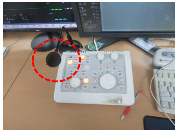
图 3-10 控制室对讲设备
