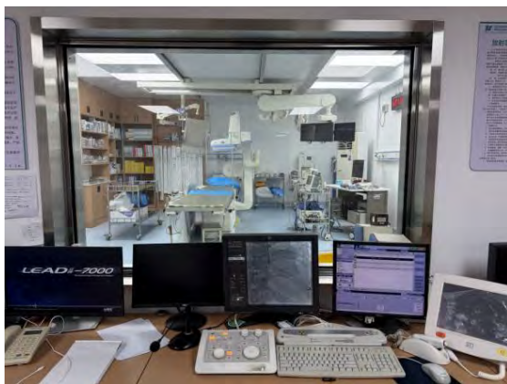
图 3-9 控制室铅窗及操作台
