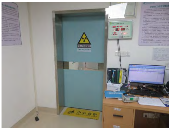
图 3-7 控制室防护门
